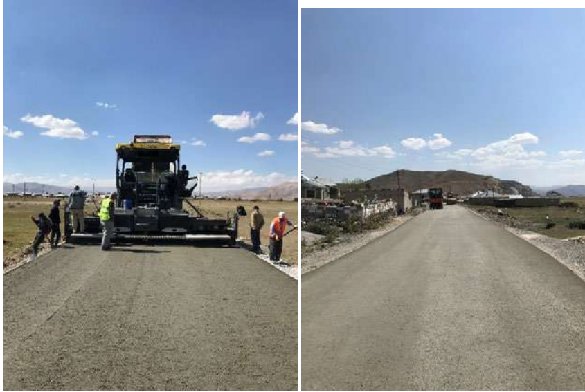
Şekil 7. Asfalt serici ile betonun yerleştirilmesi ve çelik bandaj ve tekerlekli silindirlerle sıkıştırılması
