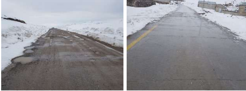
Şekil 1. Sathi kaplama köy yolu (solda), silindirle sıkıştırılmış beton köy yolu (sağda)
