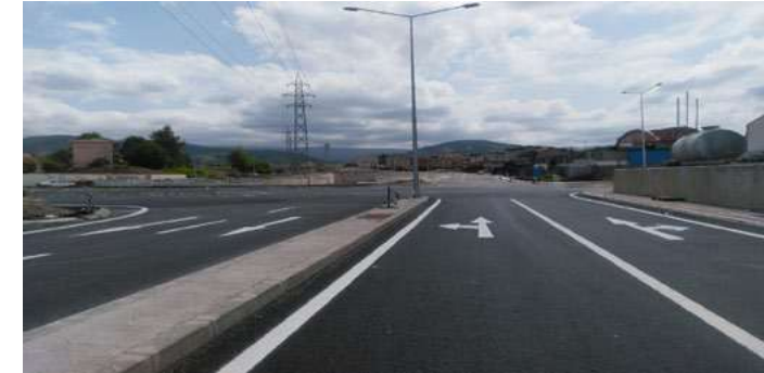
Şekil 7. Kaplamanın bitmiş hali (2017)
