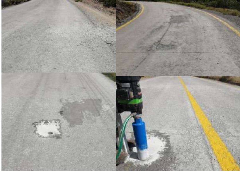
Şekil 1. Stabilite Kaybı Yaşamaya Başlamış Yol Kısımları
