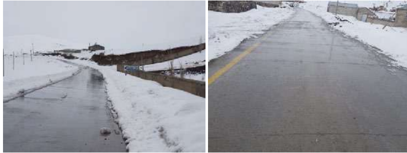
Şekil 9. 2021 yılında yapılan beton yolların durumu (Mart 2022)
