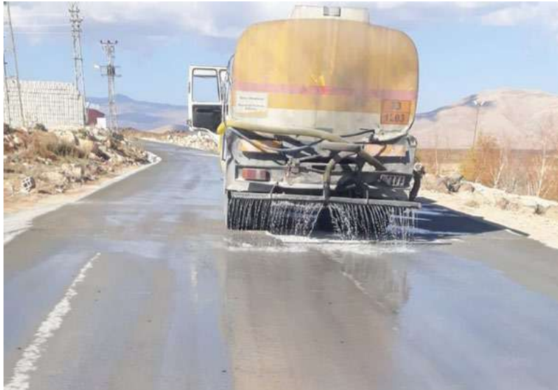
Şekil 8. SSB'nin geleneksel sulama yöntemiyle kürlenmesi
